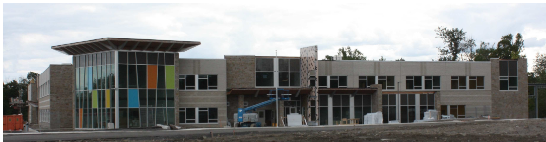
L'École 033, encore en construction dans le secteur Connaught.
